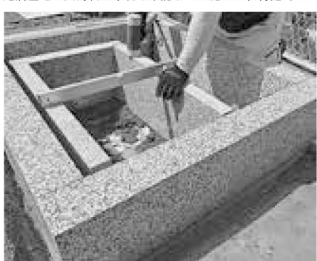
犬島石で制作した五輪塔の施工風景
